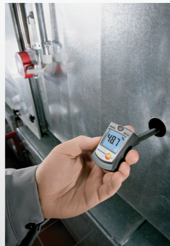
Monitoring wilgotności powietrza w kanałach wentylacyjnych i klimatyzacyjnych
