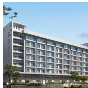
Niższe budynki wielkopowierzchniowe
