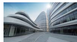
Niższe budynki wielkopowierzchniowe
